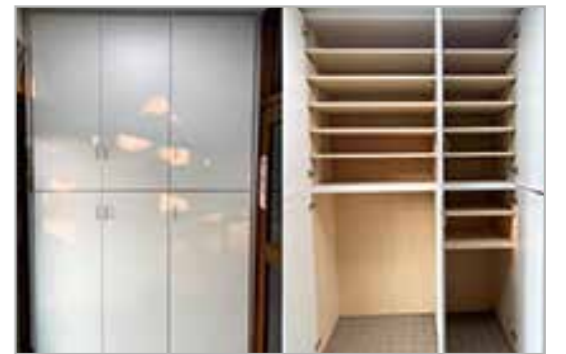
札幌村郷土記念館の収納棚の設置工事
