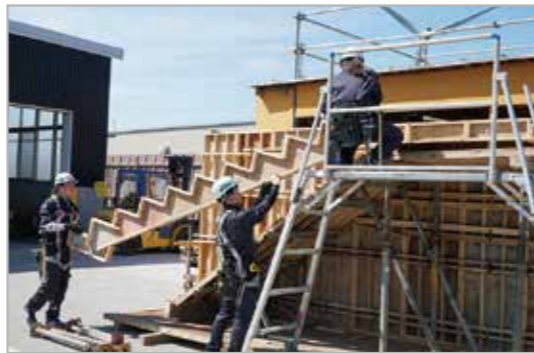
実技訓練としてミニチュア型枠を製作
