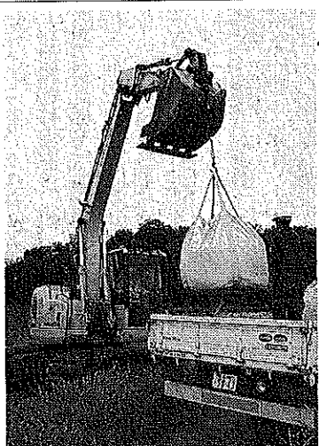
土のうを油圧ショベルで設置した
