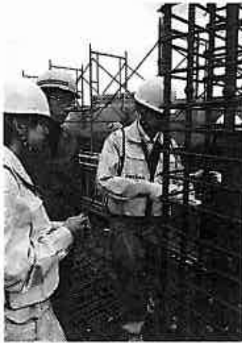
指導を受けながら鉄筋作業も体験した
