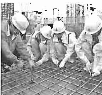
実際の工事に携わる形で、スラブ結束作業を行った
